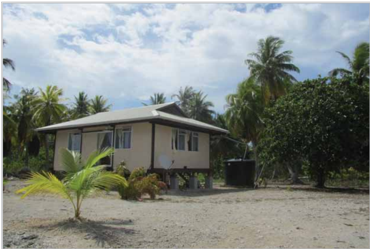
Figure 7 : Une maison en kit faiblement surélevée à Rangiroa. Photographie : Anna Rios Wilks (décembre 2012).
