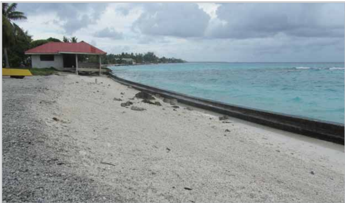
Figure 6 : Un muret de protection côté lagon à Avatoru, muret qui n'empêche pas l'érosion de la plage. Photographie : Anna Rios Wilks (décembre 2012).
